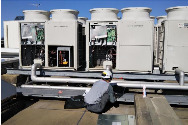
フロン排出抑制法に基づく空調機器の定期点検
