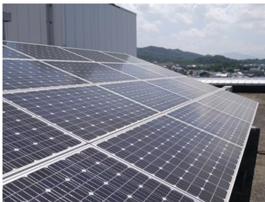
太陽光パネル
